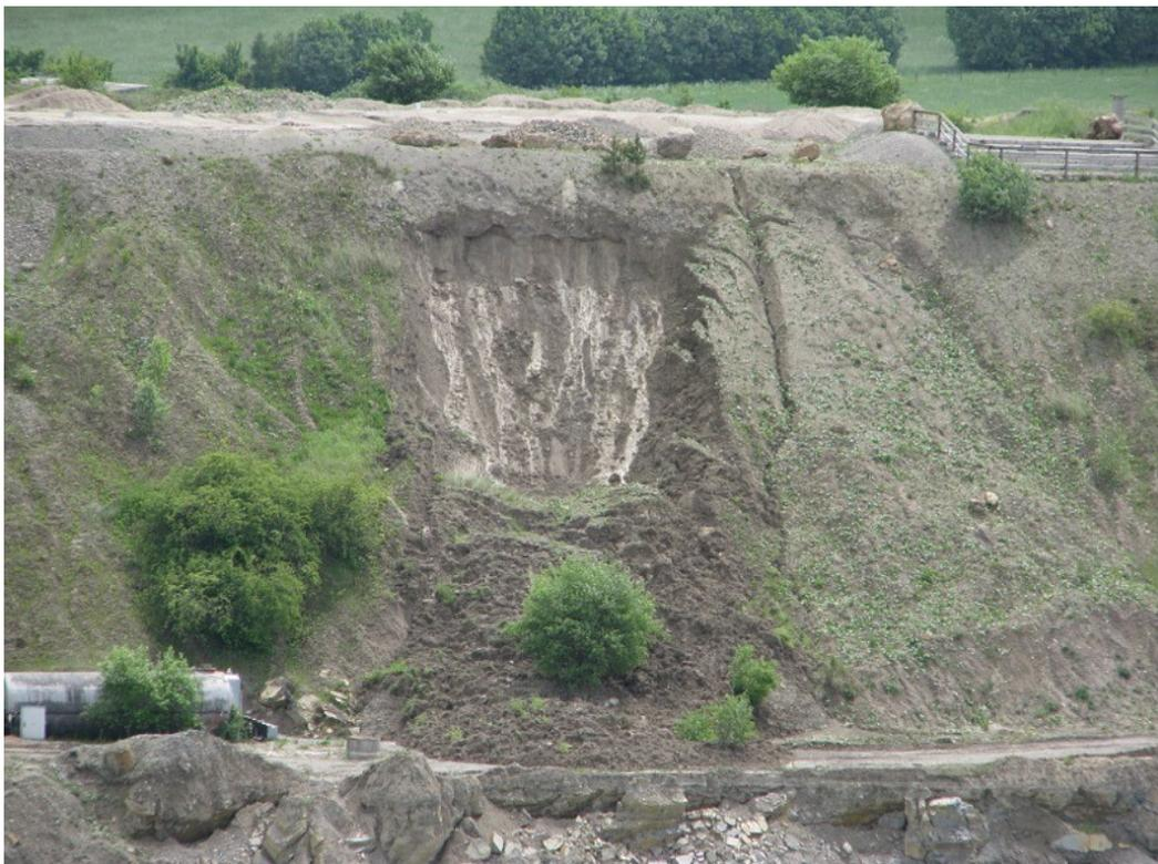
Der Steinbruch der ZKW Otterbein in Großenlüder nach dem Böschungsrutsch
